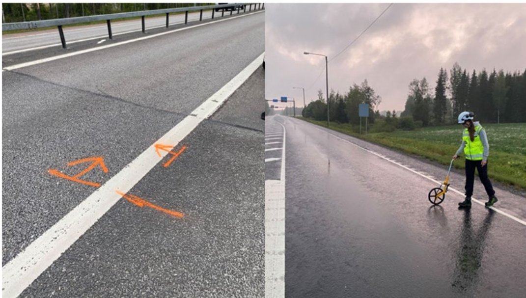
Kuva 6. Vasemmallä kuvassa on merkitty päällysteeseen toteutusleveys ja oikealla kuvassa tarkastetaan päällysteen leveyttä mittapyörällä. (valokuvat: Alina Koskinen).
