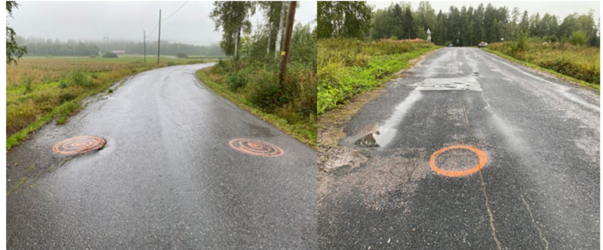
Kuva 12. Päällysteeseen merkittyjä poistettavia maakiviä kohteella (valokuvat: Alina Koskinen).
