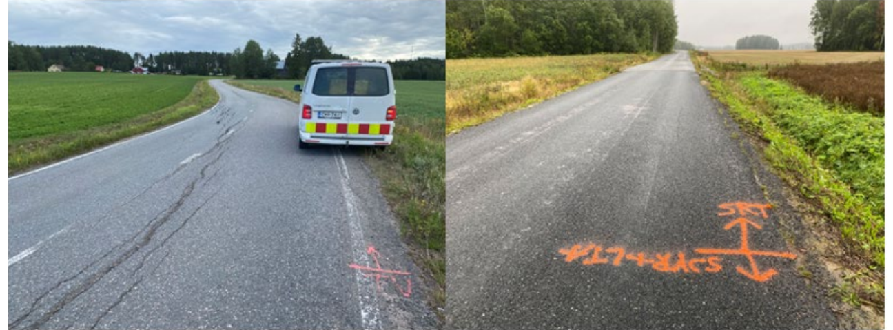
Kuva 13. Esimerkki eri toimenpiteiden aloitus- ja lopetuskohtien merkitsemisestä päällysteeseen (valokuvat: Alina Koskinen).
