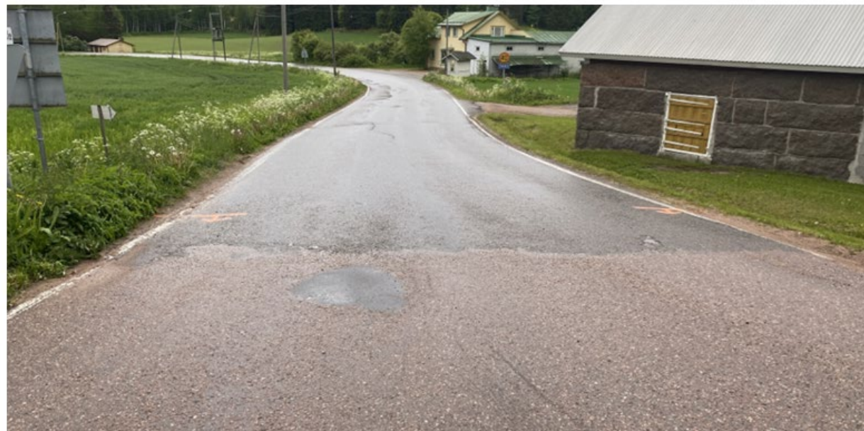
Kuva 11. Liittymässä risteävän tien suuntaan päällystyslaajuus on merkitty päällysteeseen (valokuva: Alina Koskinen).
