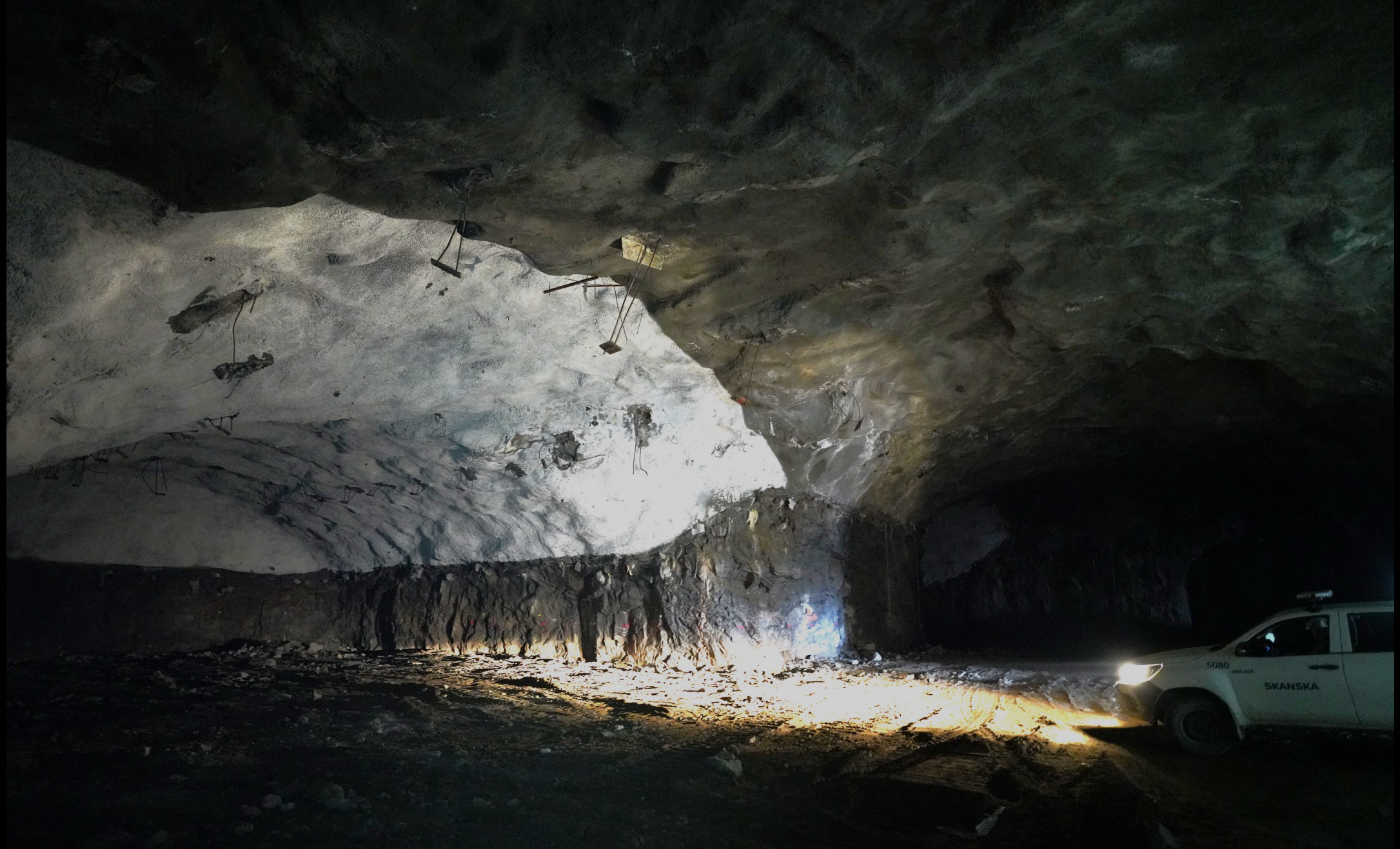
Tilanne purkutöiden päätyttyä, ennen louhintatöitä 31.8.2021
