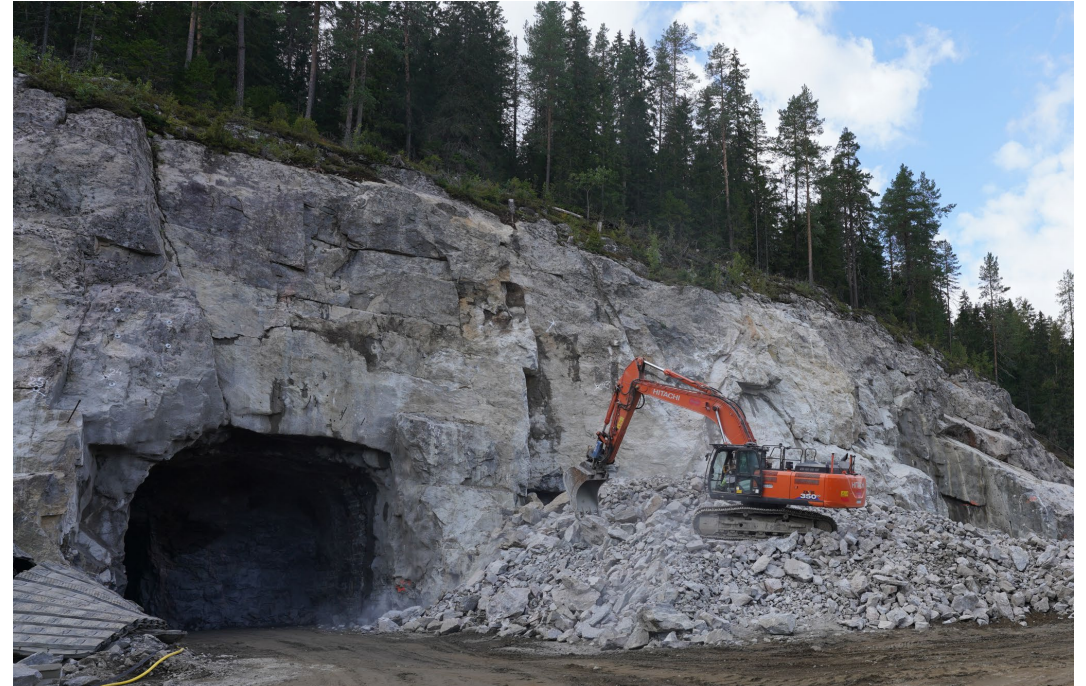
Piha-alue tunnelit 3 ja 4, 31.8.2021
