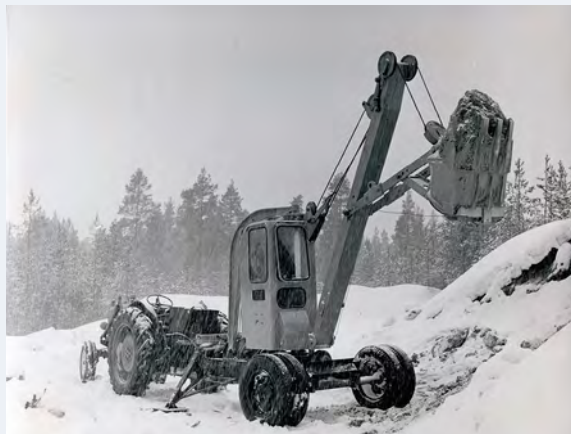
Erilaisten kaivulaitteiden rakentamisessa ei suomalaisen kekseliäisyys ole tuntenut rajoja. Tässä traktorin vetämä kaivukone, jonka kuljettajaa ei hemmoteltu liialla mukavuudella.
