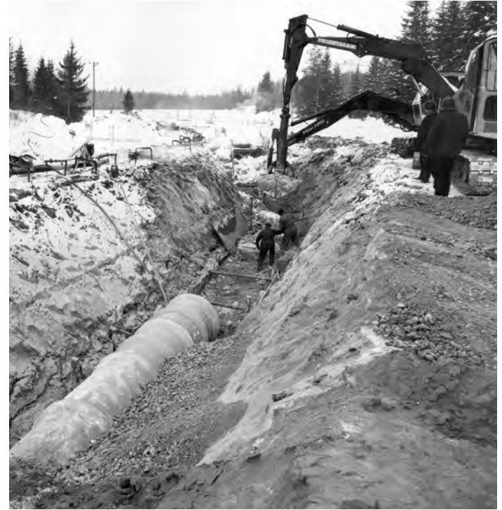
Pohjavedenalennusta 1970-luvulla tyhjiöpumppauksella Friherssin runkoviemäriyömaalla Helsingin maalaiskunnassa.
