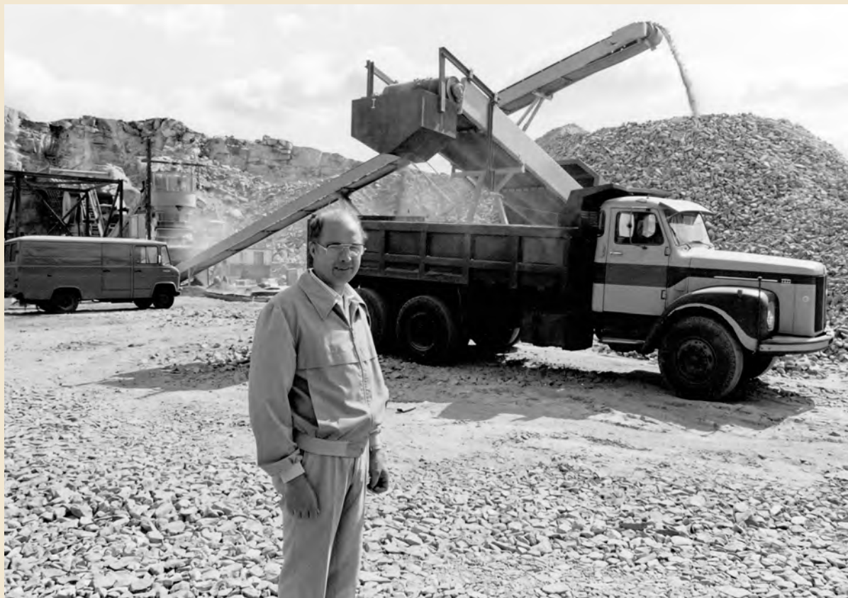
Maanrakennusliike Armas Kallio Oy:n toimitusjohtaja Armas Kallio soralouhoksella Huolintakeskuksen tontilla Seutulassa 1984.
