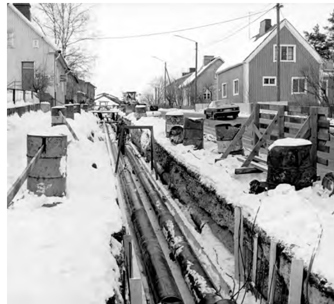
Kaukolämpöverkoston rakennustöitä pientalo-alueella Helsingissä 1980-luvulla.
