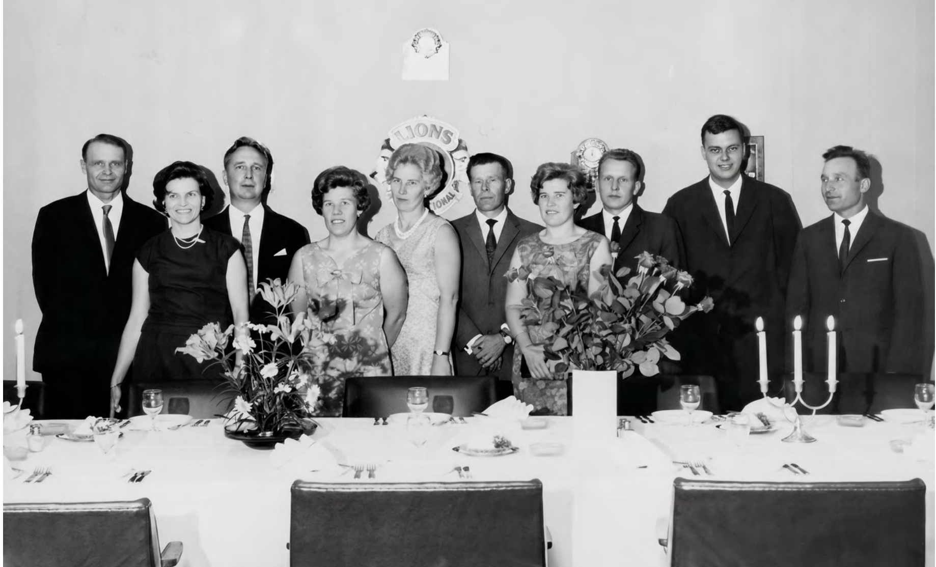
Helsingin Maansiirto Oy oli SML:n Uudenmaan piiriyhdistyksen perustajajäseniä. Yhtiö perustettiin nimellä Karlsson & Kni jo 1955, mutta se muutti nimensä Helsingin Maansiirroksi seuraavana vuonna. Yhtiö oli mukana mm. Tarvontien ja Jorvaksen moottoritien rakentamisessa. Kuva yrityksen 10-vuotisjuhlista 1966.
