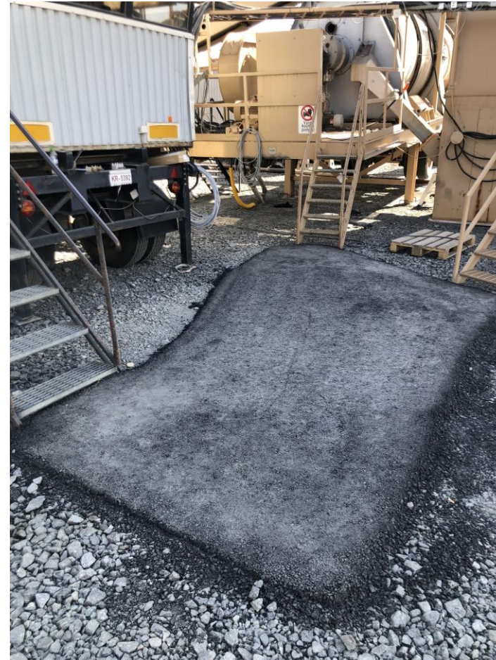
Positiivinen havainto. Asfalttiaseman ohjaamon portaiden edusta asfaltoitu, estää kompastumisia
