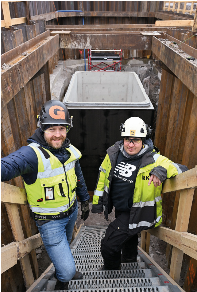
”Elementtirakenteisen pumppaamon työmaa-aika on merkittävästi lyhyempi kuin perinteisesti paikallavaletun pumppaamon työmaa-aika”, GRK:n työpäällikkö Roope Korpela ja työnjohtaja Joel Ruotanen vertaavat.
