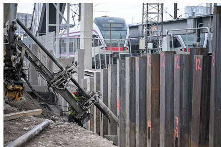
KFS Finlandin ankkurointivaunu poraa ankkurille suojaputkea, jonka sisään ankkuri myöhemmin asennetaan.
