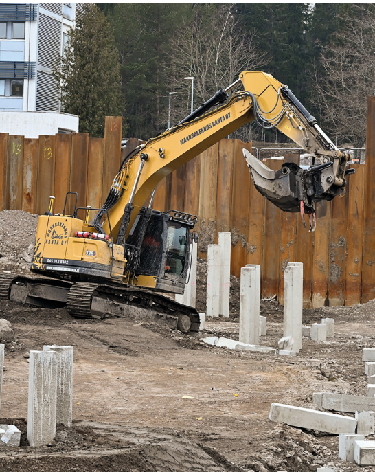
Maanrakennus Rannan toimitusjohtaja Jouni Ranta on kuvassa rakentamassa paalulaatan pohjia. Katkaistujen paalulaattojen jäämät on tarkoitus toimittaa GRK:n ympäristöliiketoiminnalle, joka tekee niistä EEJ-betonimurskaa.
