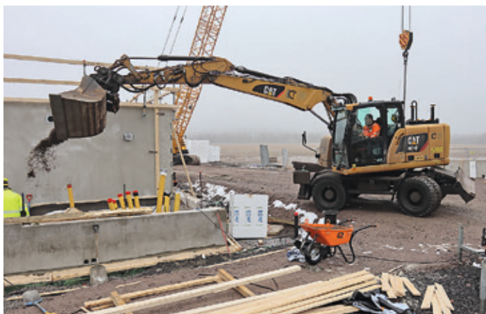
Pohjatyöt ovat tämän projektin osalta valmiit. Tässä ovat jo käynnissä täytöhommat. Pohjatyömaiden lisäksi Kummalan pyöräalustaisia koneita toimii lähialueen kaupunkien ja kuntien konepalvelutehtävissä.
