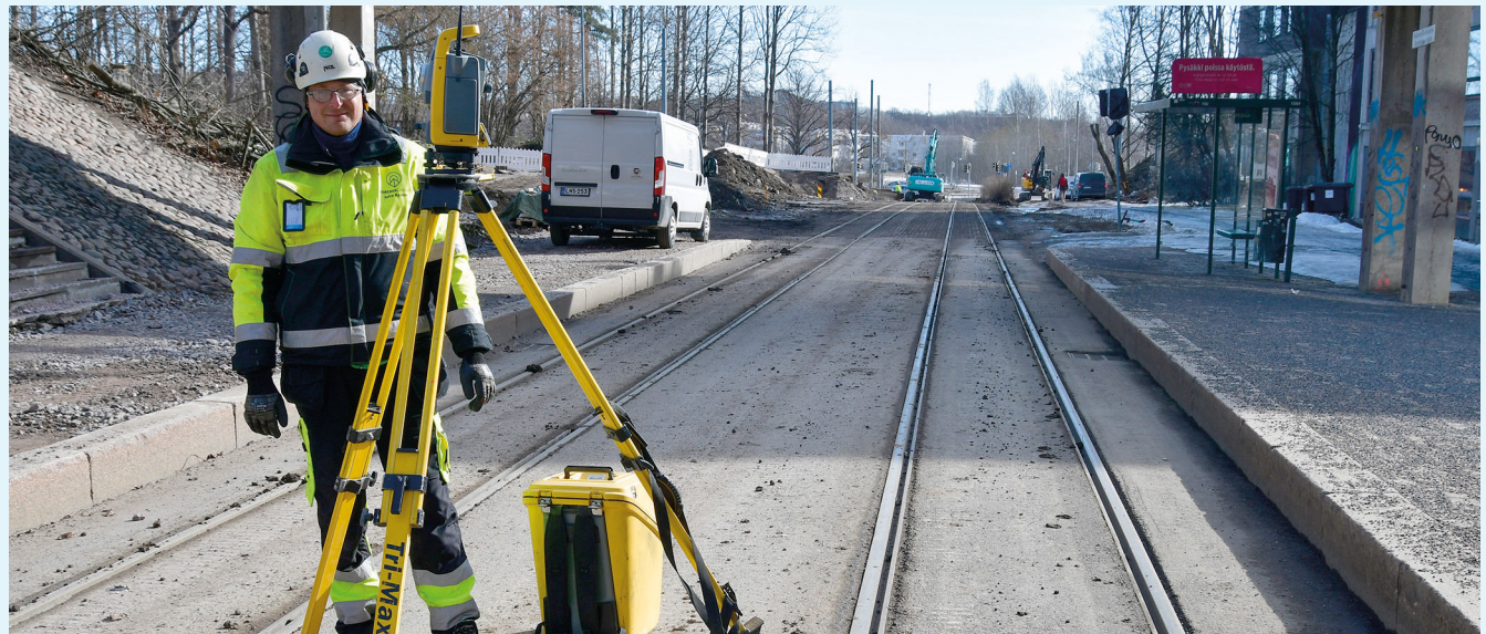
Allianssihankkeessa yhteistyö suunnittelijoiden kanssa on ollut tavallista tiiviimpää. Kuvassa MittausGroupin mittamies Juha Kousa Kalasatamassa Pasilasta -hankkeen työmaalla, Pasilan puoleisessa päässä.
