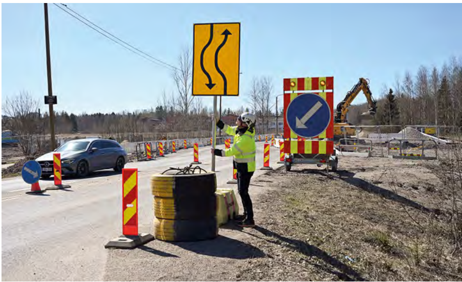
Ramuddenin Teemu Löfberg suoristaa työmaan liikennemerkkiä Kokonniemen työmaalla. Kuvassa näkyvät myös tilapäisissä liikennejärjestelyissä käytettävä sulkuaite ja työmaa-alueen suojaukset.
