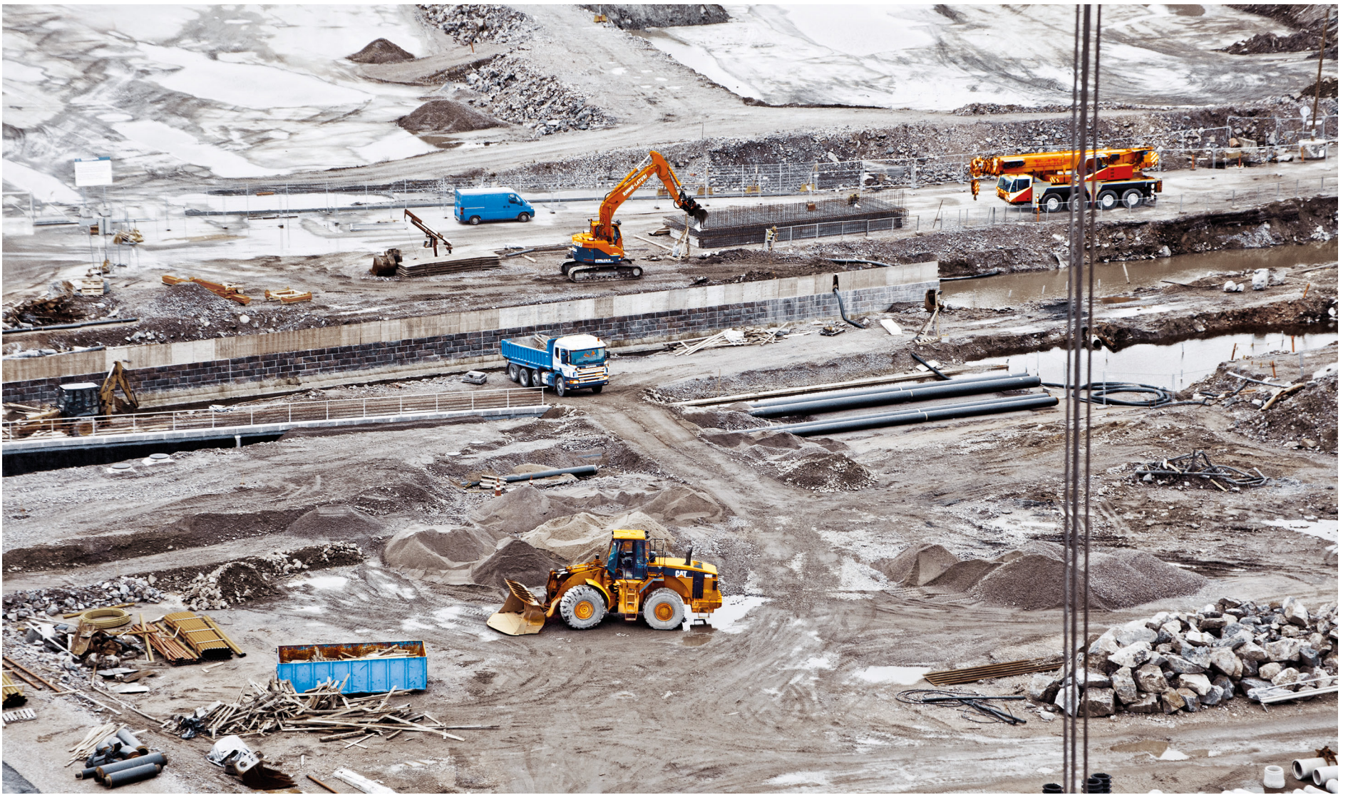
Kuvassa Lemminkäisen työmaa Helsingin Vallilassa. Työturvallisuus on kehittynyt esimerkiksi tämän kuvan ottamisen jälkeen infra-alalla merkittävästi, vaikka tänä vuonna oli valittavia kuolemantapauksia.
