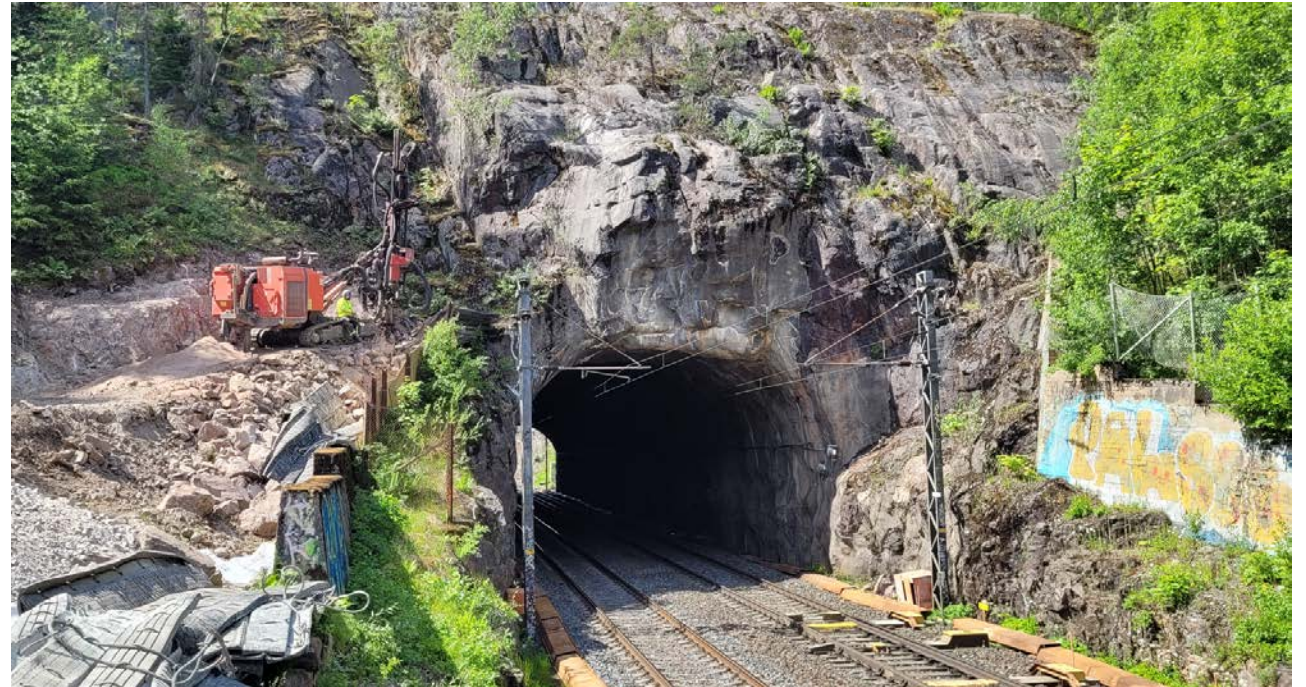
1. suuaukko kesäkuussa 2022. Käynnissä louhintatyön valmistelut ja ennakkolujituspulttien poraus. (Kuva: Sweco, 2022)
