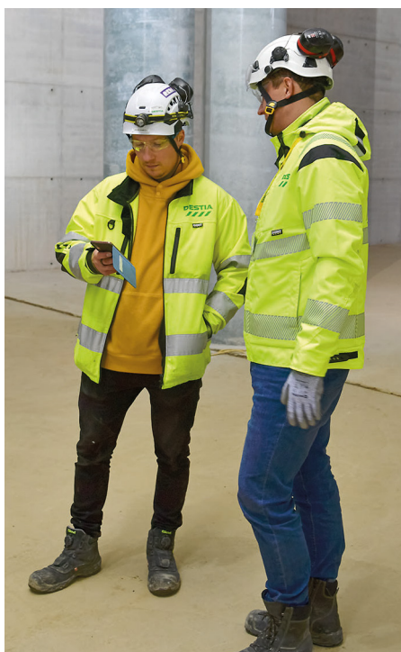
livari Kanto ja Juha Viitala päivittävät pyöräpar- kin rakennustöiden tilannetta.
