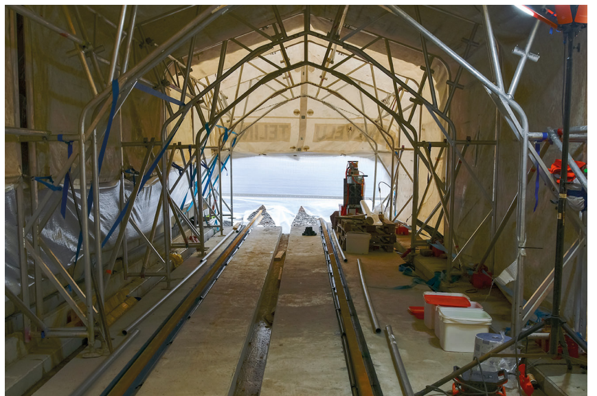
Länsipäässä raiteita valetaan betonikanteen kiinni.
