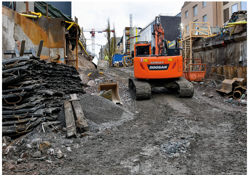
Työmaa tunnelin itäpäässä.
